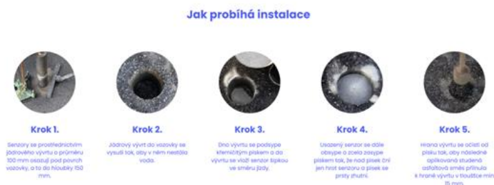
Obrázek 3 Magnetometr a jeho instalace (Citiq s.r.o., 2021)
